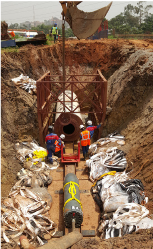
Рис 4: Монтаж на место молота TR 565 с промежуточными кольцами.
