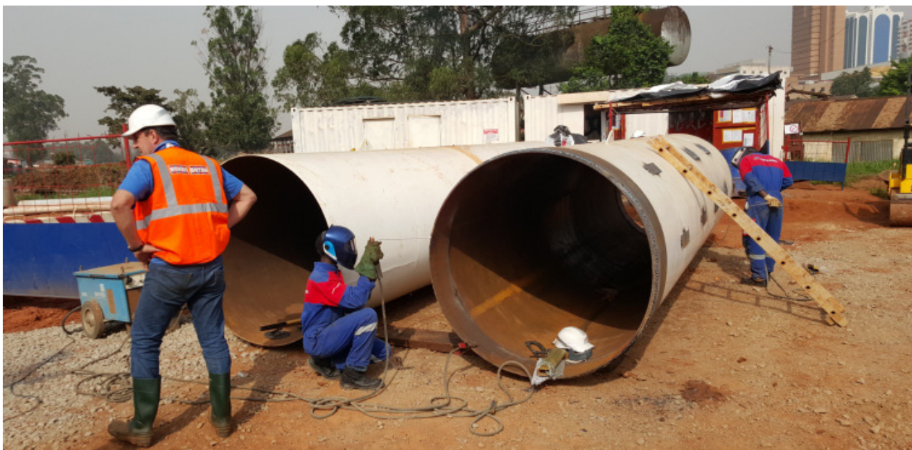
Рис 1: Изготовление режущего кольца на передней стальной трубе. Этот усиленный "нос" стальной трубы будет предотвращать деформацию в суглинисто - песчаной почве столицы Кампала.
