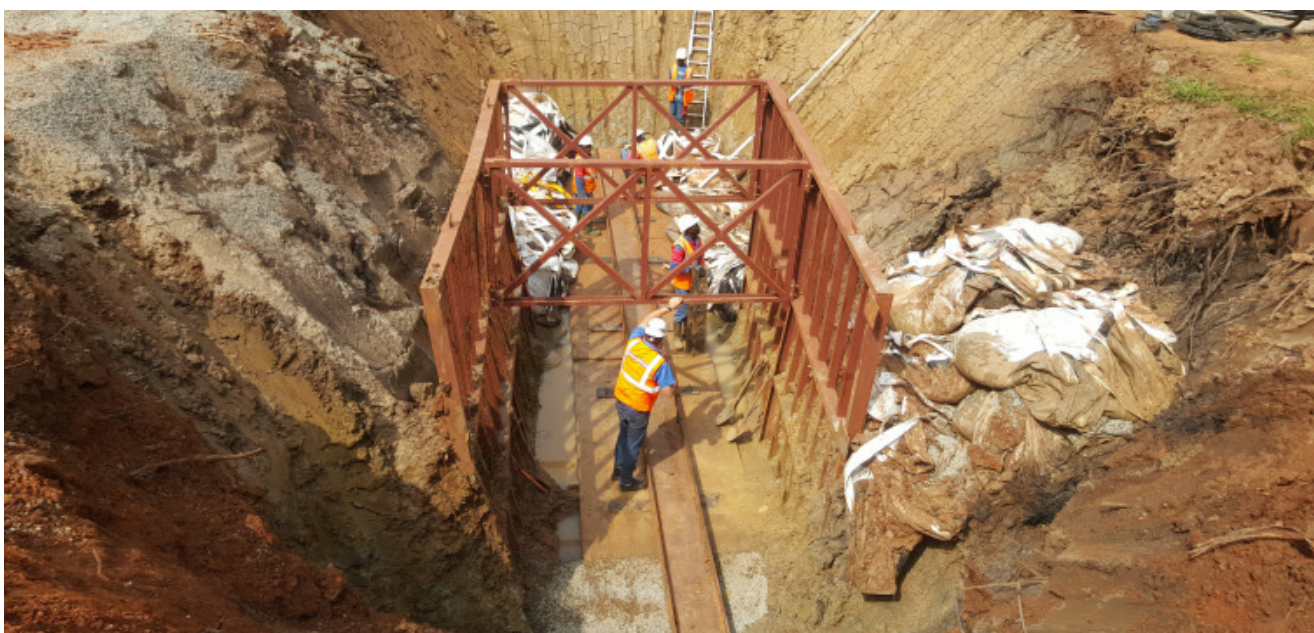
Рис 2: Информация о безопасном благоустройстве траншеи для забивки стальной трубы помогла в работе.
