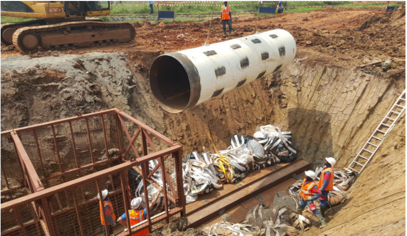
Рис 3: Установлен первый участок трубы \varnothing 1'500 мм для забивания.
