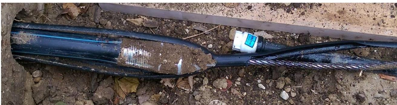
Рис 6: Затянутая полиэтиленовая труба с наружным диаметром 40 мм после затягивания в TERRA-EXTRACTOR X 100. Обновление водопровода к дому в местечке Weiden фирмой Altenthaler Bau GmbH удалось реализовать за немногим в один день, в том числе подключение к основной линии под давлением. Для жителей дома это означало отказ от потребления питьевой воды менее чем на полдня.
