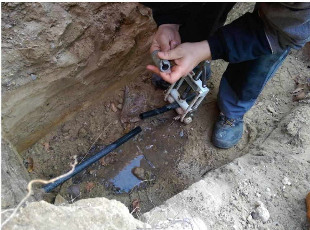
Рис 1: Траншея с минимальными размерами 0.65 x 0.40 м.
