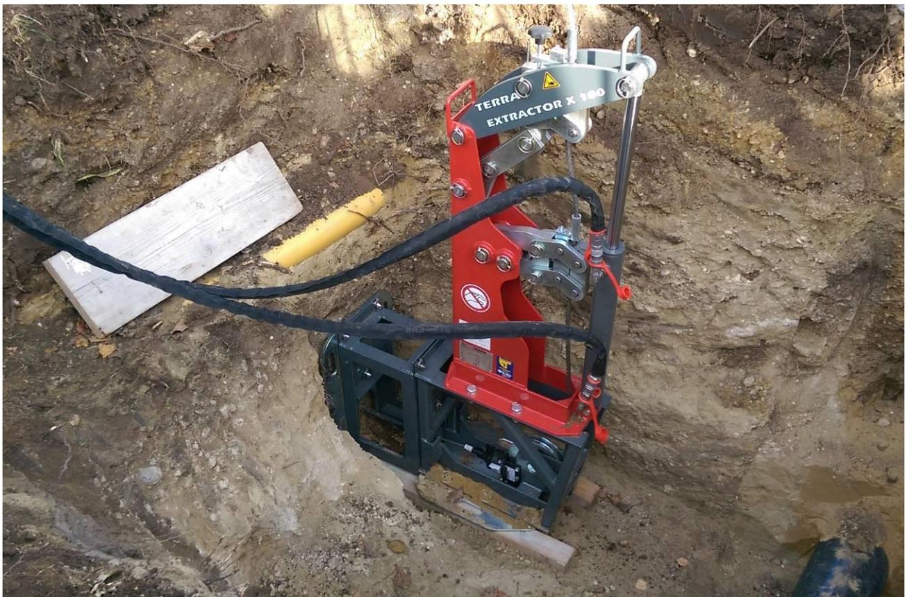
Рис 3: Трос протянут внутри старой трубы и через установку ТЕРРА. Необходимо разрушить 12 м старой трубы под тротуаром, оградой, участком и под палисадником.
