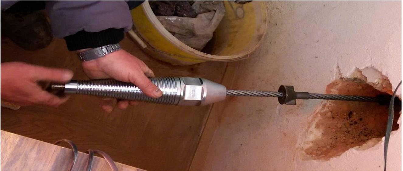
Рис 2: В подвале по стене проложена старая труба с фитингами и втулками. Необходимо проложить внутри трубы трос с помощью которого будет затянута новая труба.
