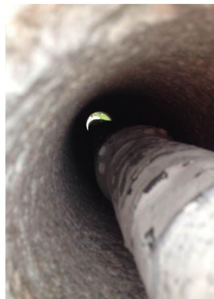
Фото 5: Буровой канал изнутри.
