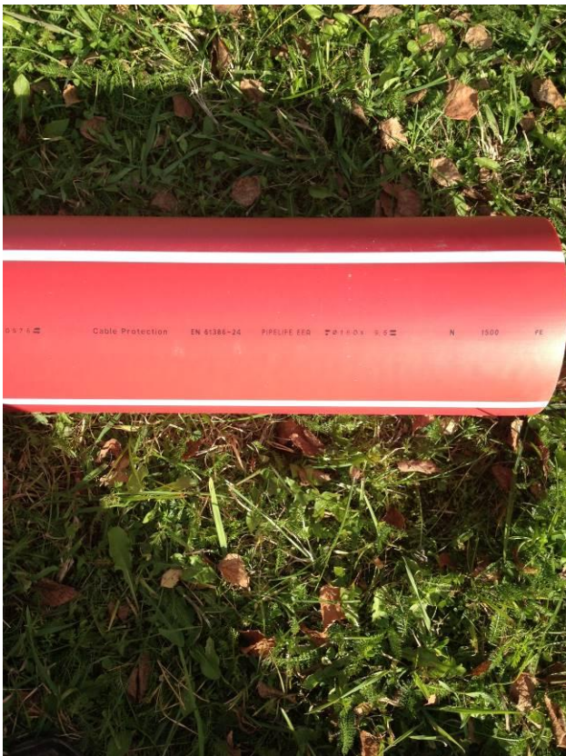
Фото 3+4: После успешного пилотного бурения была установлена расширительная головка 215 мм для затягивания ПЭ защитной трубы 160 мм для электро кабеля. Потребовалось только один с половиной часа, и труба была затянута на 65 метра.
