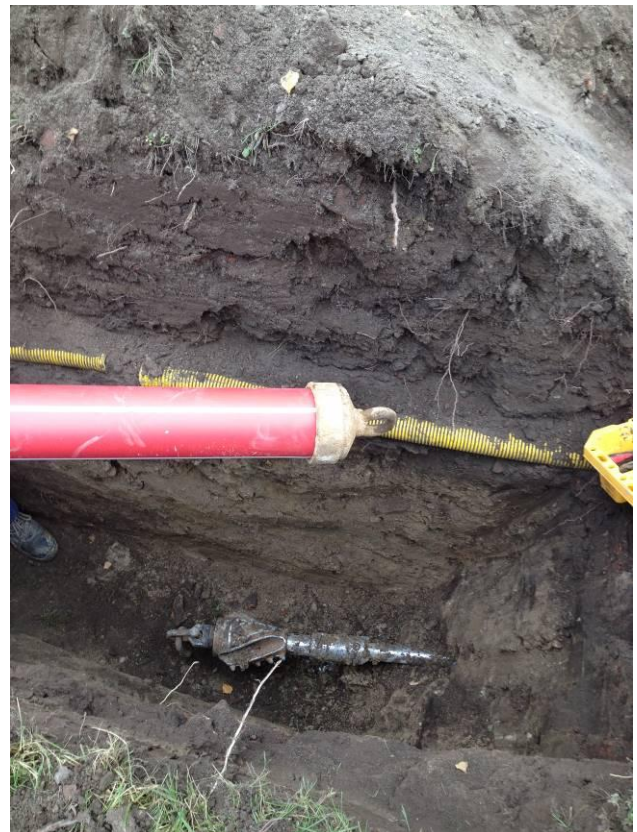
Фото 3+4: После успешного пилотного бурения была установлена расширительная головка 215 мм для затягивания ПЭ защитной трубы 160 мм для электро кабеля. Потребовалось только один с половиной часа, и труба была затянута на 65 метра.
