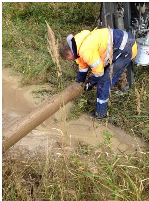
Фото 5: Было израсходовано 5,800 литров бентонита. Насос высокого давления производительностью 100 л / мин является стандартом для TERRA-JET TJ 2808 S.
