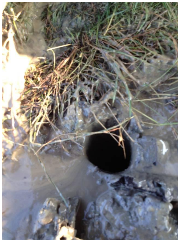
Фото 7: Nach 1 ½ Stunden waren 25 Meter vertikal gebohrt. Damit das Bohrloch \varnothing 100 mm sauber bleibt und nicht zusammenfällt, wurden 100 ltr/min Bentonit in das Bohrloch gepumpt.
