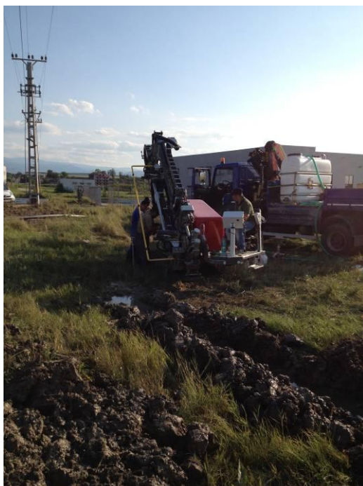
Фото 5: Подготовка TERRA-JET TJ 2808 S к вертикальному бурению. После ок. 30 минут установка готова.
