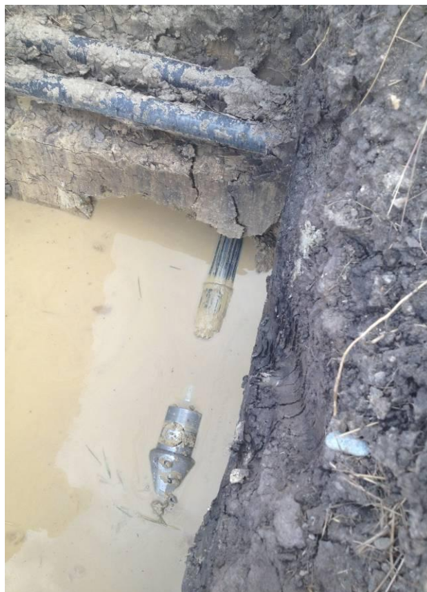
Фото 3+4: После успешного пилотного бурения вместо буровой головки смонтирован расширитель DA 160 mm, за которым затягивается ПЭ труба 110 мм. За 30 минут труба длиной 35 метров затянута.
