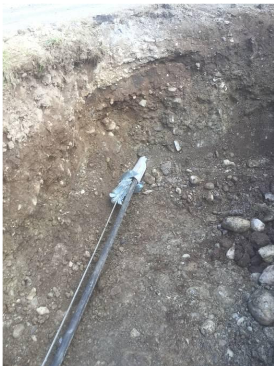
Фото 6: Труба DA 112 мм проложена рядом с двумя DA 92 мм.
