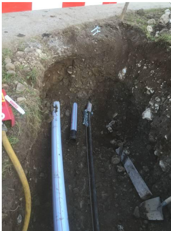
Фото 6: Труба DA 112 мм проложена рядом с двумя DA 92 мм.
