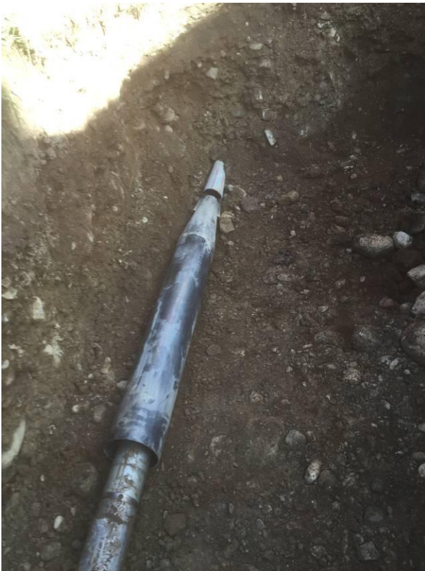
Фото 2: TERRA-HAMMER T 105 S толкает расширительную гильзу.
