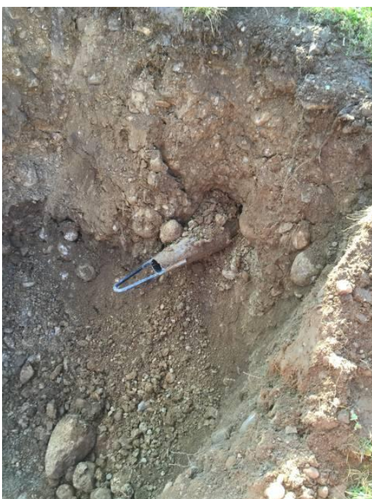
Фото 5: Расширительная гильза успешно добралась до цели.
