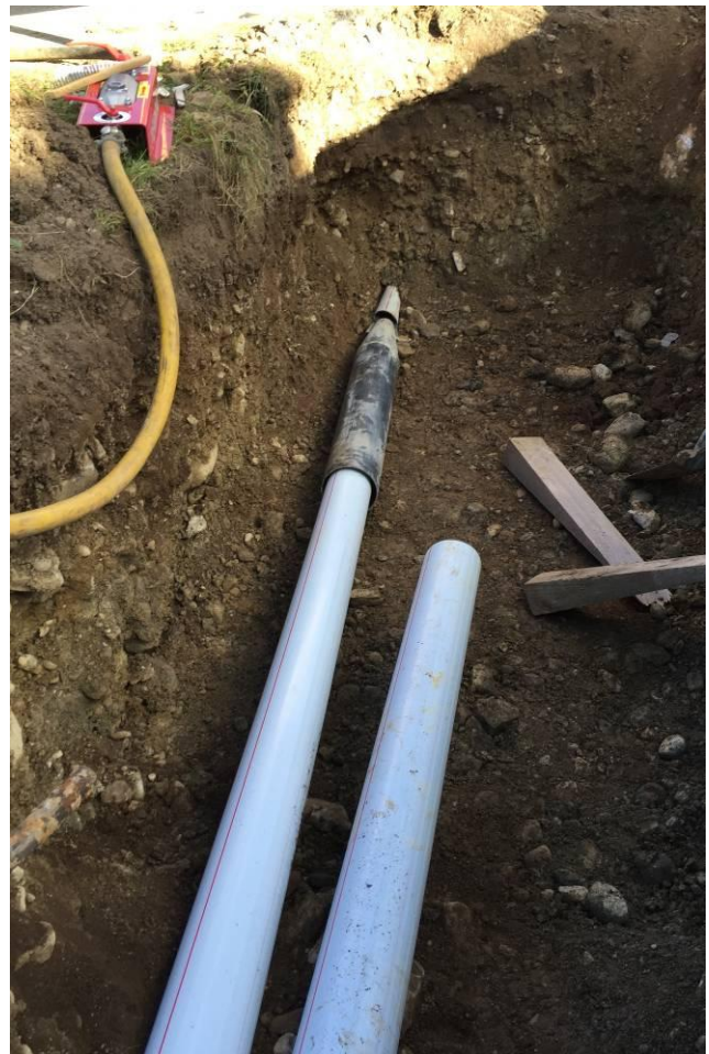
Фото 3: Защитные трубы DA 112 мм затягиваются после расширительной гильзы. В пилотный канал затягивается защитная труба после расширительной гильзы.
