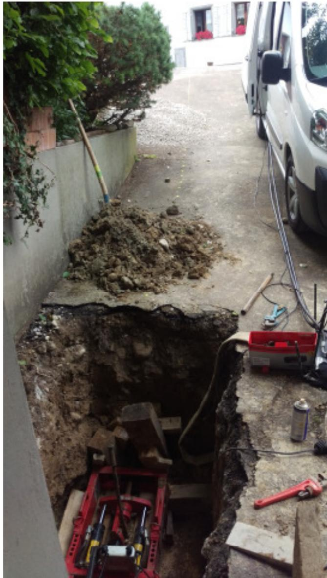
Рис 1: Стартовая траншея была выкопана на дороге, в ней размещён пресс-бур TERRA-JACK который приготовился и провёл пилотное бурение.
