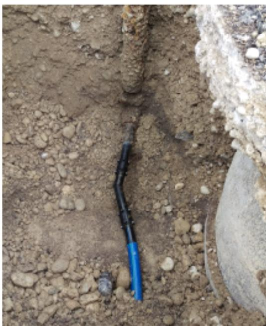
Рис 7: Повреждённая старая труба была отсоединена от основной линии и подключена новая труба.
