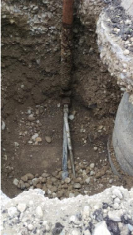
Рис 2: Головка прессы успешно достигла финишной траншеи.
