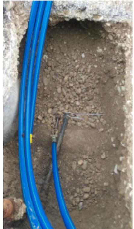
Рис 3: После пилотного бурения прессголовку удаляют, а затем устанавливают расширительную головку за которой крепится затягиваемая труба.
