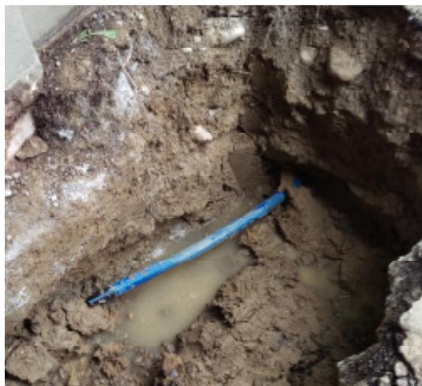
Рис 6: В центре фото втянутой защитной трубы OD 50 мм.
