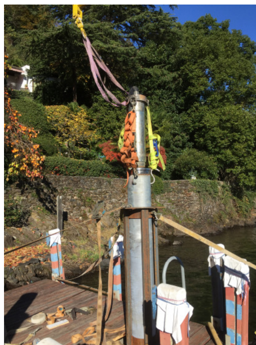
Рис 5: TR 200mini с забиваемой стальной трубой.
