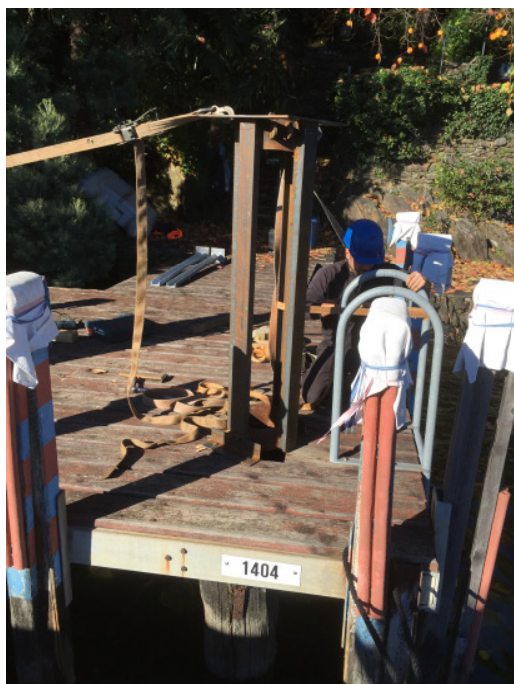
Рис 4: Для вертикальной стабилизации стальной трубы, направляющая привинчена и выровнена по старому мосту.
