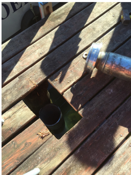
Рис 6: Столбики для фундамента забиты. Начальная стадия строительства нового причала завершена.
