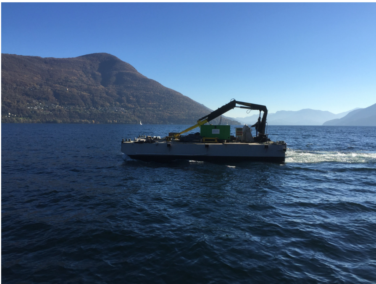
Рис 1: Рабочая платформа на озере Лаго-Маджоре. Она оснащена краном, воздушным компрессором и аварийным генератором. Стальные трубы и TERRA HAMMER поднимались с помощью портового крана на понтоне.
