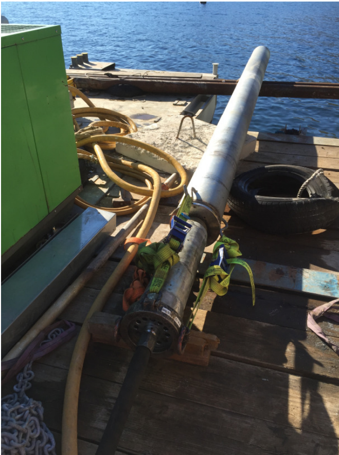
Рис 2: Стальная труба, промежуточные кольца и TERRA HAMMER прижимаются друг к другу с помощью трех ремней. Нажимное кольцо на заднем конце TERRA HAMMER имеет пять точек крепления.
