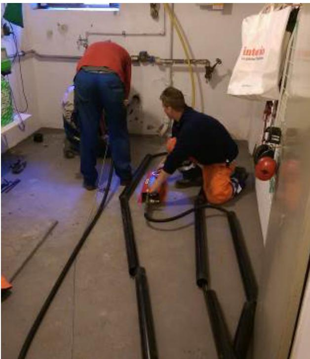
Однометровые трубы Hauff-Zappo уложены и будут соединяться „защёлкиванием“.
