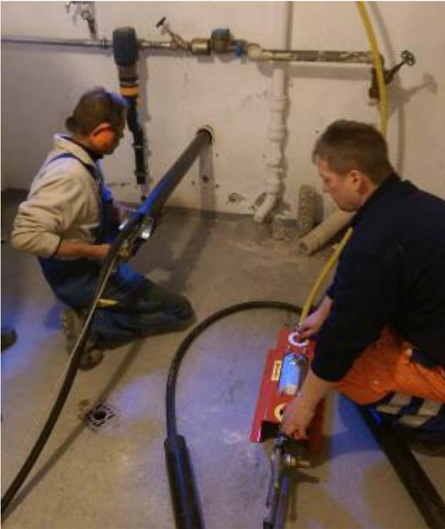
TERRA-HAMMER T 080 mini SK с расширителем на конце в Ø 90 мм стартует из подавала
