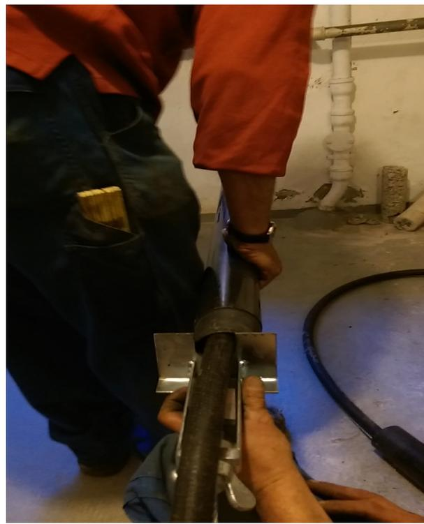
Короткие трубы Ø 75 мм легко соединяются методом защёлкивания.
