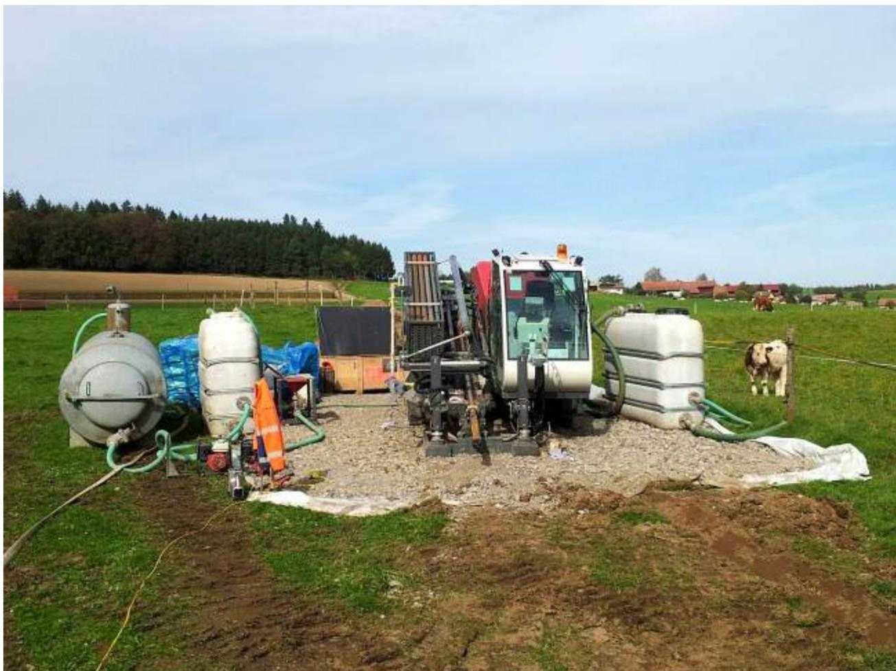
Обзор на установку TERRA-JET 8522 S и дополнительного бака смешивания второй станции (на фото выше). На нижнем фото ручей под которым проложены две пластиковые трубы в каменистом грунте. Тем не менее, успешное пилотное бурение и необходимые расширения (на фото справа) были успешно сделаны. Очень помогла новая буровая управляющая головка мультипин.
