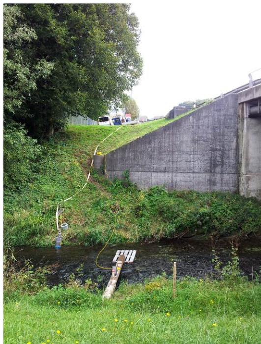
В общей сложности были сделаны два прохода под ручьём в тяжёлом грунте. Расширение большого диаметра было сделано на длину 120 м, с максимальной глубиной в 13 м. Второе отверстие было сделано на длину 86 м и глубиной 8 м. Для приготовления бентонита была подключена к основному резервуару дополнительный бак, для непрерывного бурения (фото справа).
