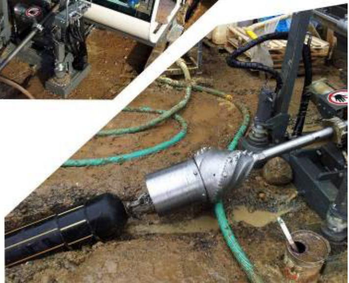
В этой твердой земле было сделано три промежуточных расширения: 215 мм, 300 мм и 360 мм, трубка диаметром 360 мм была успешно затянута за три часа.
