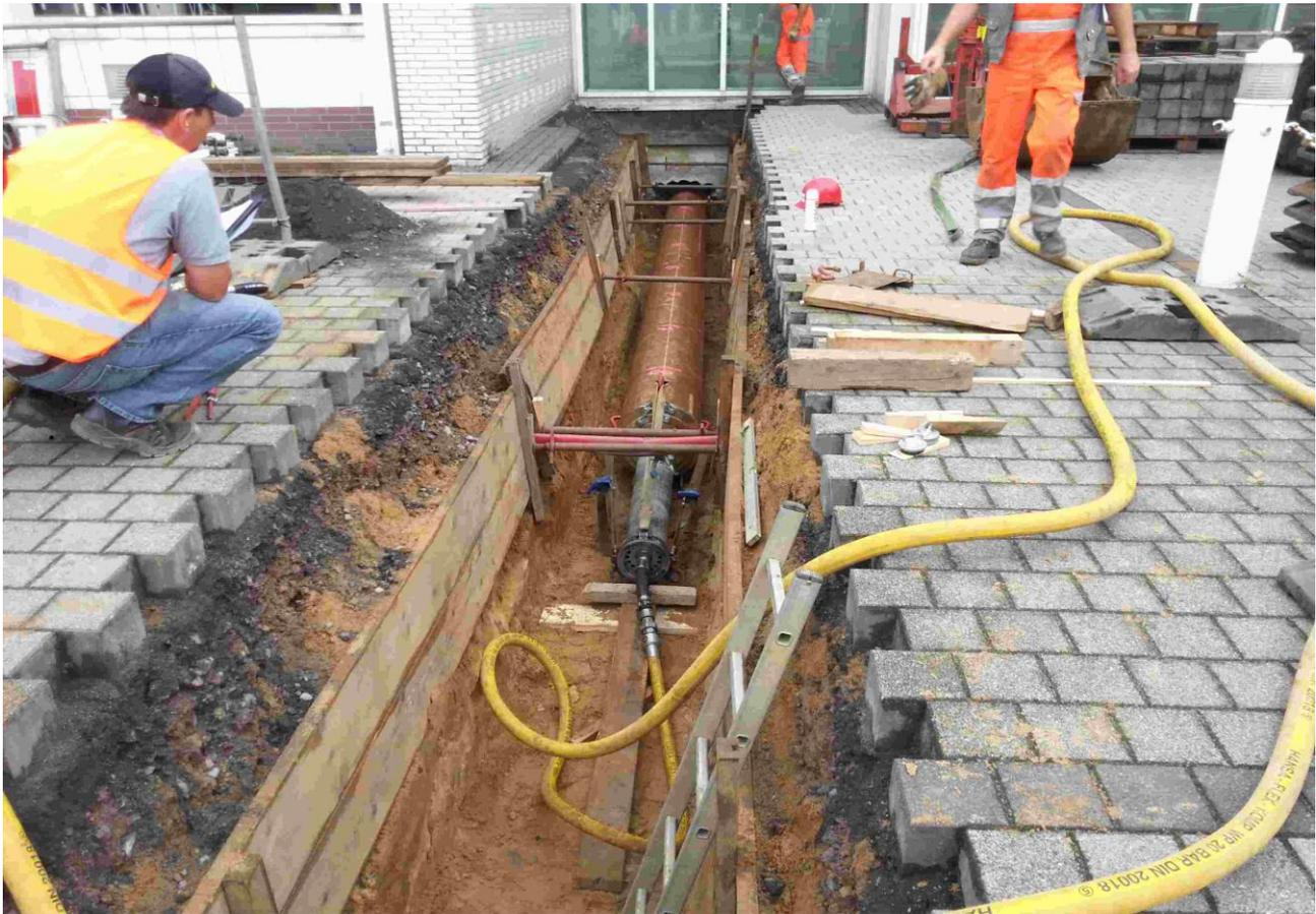
Канализационную трубу Ø 400 мм с нужным уклоном взялась проложить Фирма Erich Thesing GmbH из местечка Vocholt, для этого нужно вначале забить защитную стальную трубу Ø 500 мм, на длину 9 метров, под зданием. Фирма Erich Thesing с 30 рабочими специализируется на подземных работах. Для этой работы они применили TERRA-HAMMER TR 220. С хорошими данными и высокой энергией удара TR 220 со скоростью от 3 до 4 минут за метр (15-20 м/ч) достиг цели.
