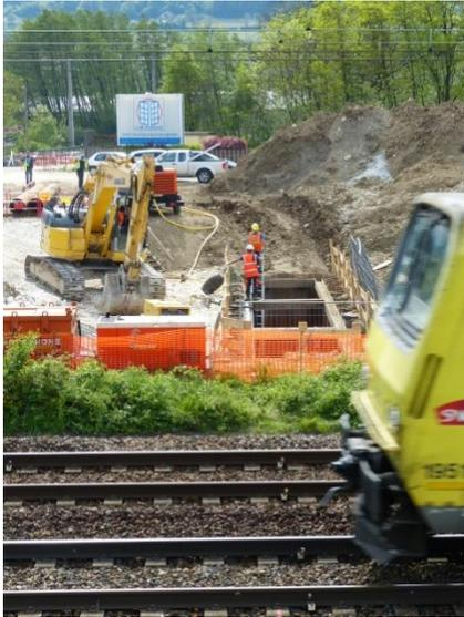
52 м забитая труба  $\varnothing$  600 мм проходит под железной дорогой, забита непрерывным методом, без остановок со скоростью от 35 м/ч до 12 м/ч на последних метрах.
