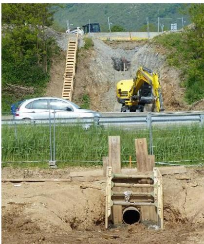
Слева: Забитая труба  $\varnothing$  600 мм длиной 39 м под автобаном.
