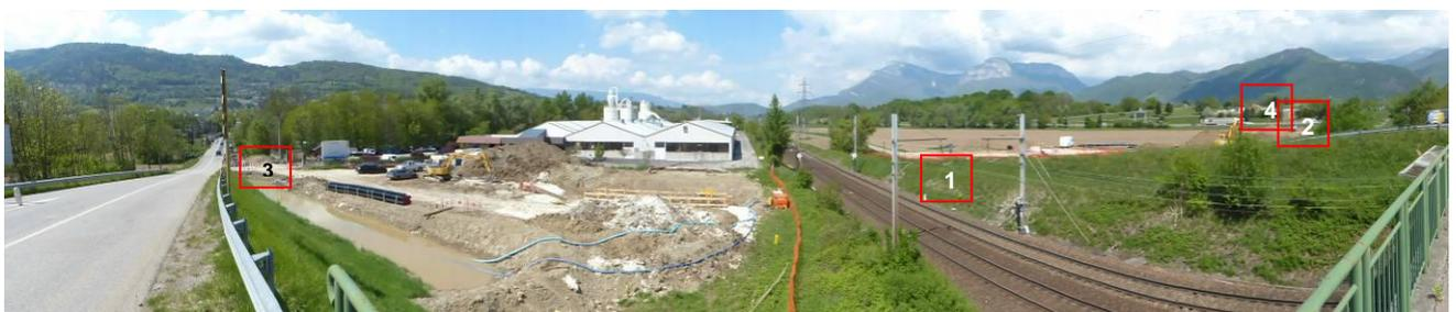
Французский специалист по глубинным работам SOGEA 38 успешно работает, теперь ему необходимо забить трубы диаметром 400 мм и 600 мм. Трубы проходят под автобаном A41 (по автобану ездят), под двухполосной железной дорогой (RFF-SNCF, связывающей местечко Grenoble с местечком Chambéry) так же велосипедная дорожка и проезд к мастерской.
