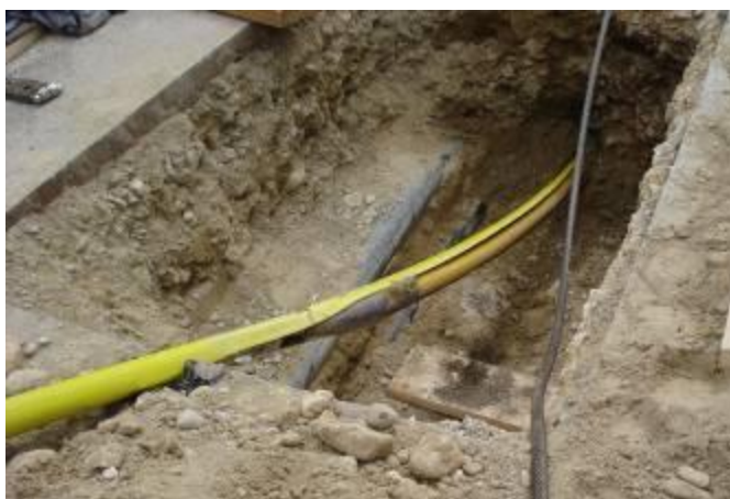
Тросовый разрушитель размещён на краю котлована и затягивает трубу на нужную длину.
