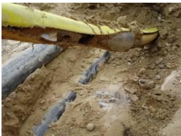
Разрушающий инструмент с новой трубой в приёмном котловане.
