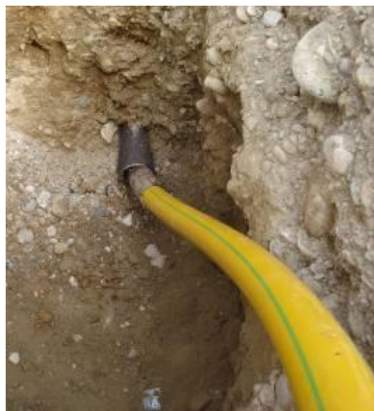
Затянута новая защитная труба фирмой Simona AG: ПЭ- DA 63 мм.
