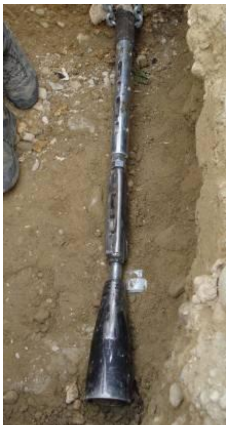
← Режущий комплект готов к работе для резки стальной трубы.
