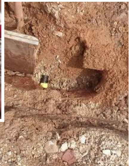
Защитная труба проложена до цели ↑
