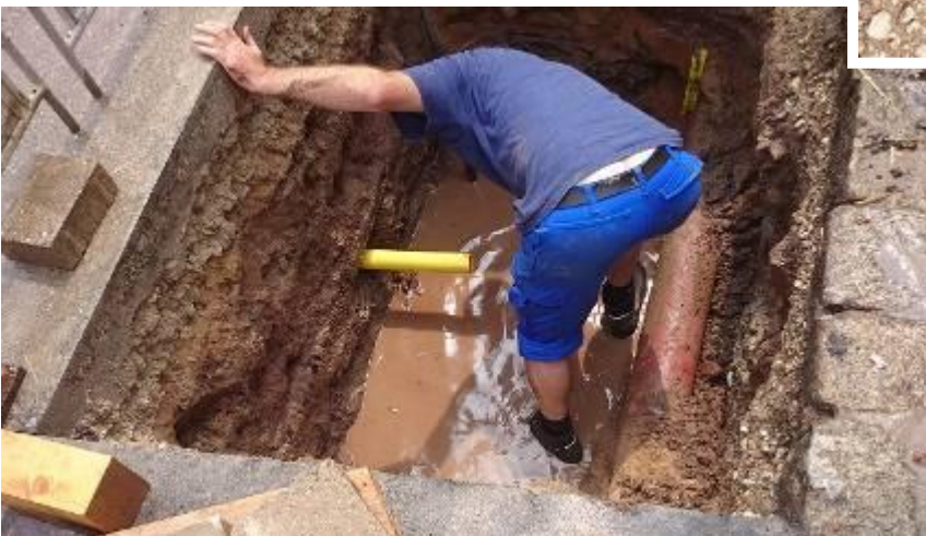
Новая труба проложена.
