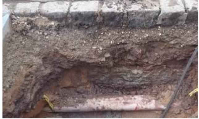
Несмотря на тяжёлый грунт TERRA-HAMMER T 080mini SK с головкой Kombikorf точно попадает в цель.
