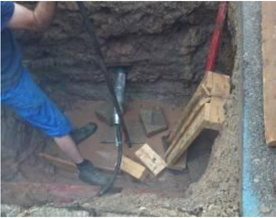
После небольшой коррекции TERRA-HAMMER начал работать.
