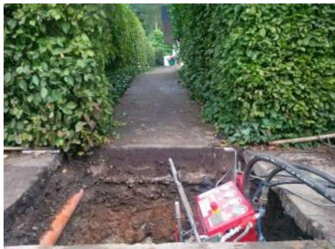
Вид на буровую трассу показывает зелёные насаждения. Буровая трасса проходила в тяжёлых грунтах. Бурение проходило с участием бурового инструмента для скал.
