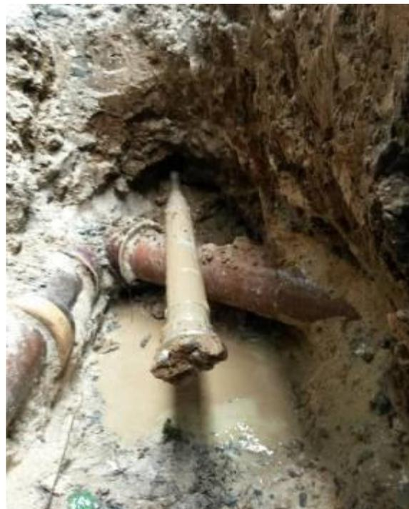
Буровая головка с точностью до миллиметра попала в цель. Трёхпальцевая головка для твёрдых грунтов хорошо работает как в твёрдом так и в мягком
