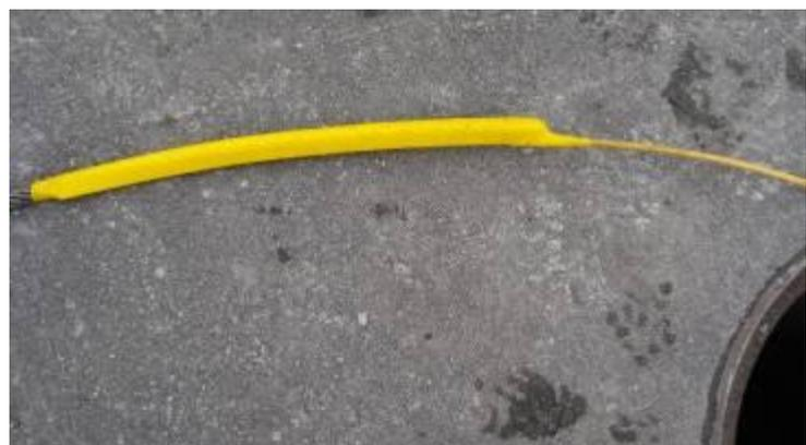
Трос Ø 22 мм соединили с «коброй» и затянули в старую трубу.
