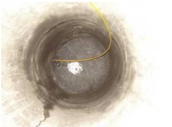
Старую линию вначале почистили водой под давлением и затем вставили пластиковый шнур («кобра»).
