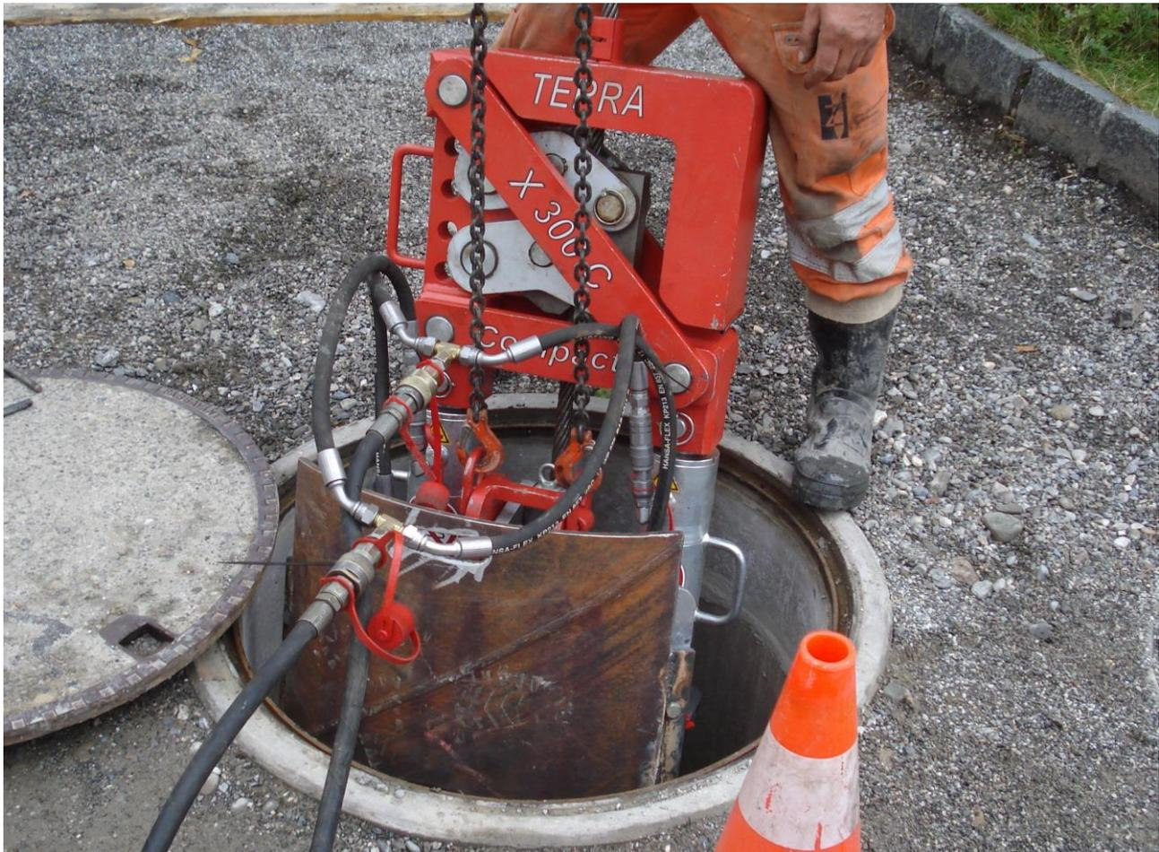
Для обновления старой канализации фирма Zehnder Spezialbau AG применила тросовый разрушитель TERRA-EXTRACTOR X 300 C. Старая линия состояла из цементных труб со множественными провалами и заплатками. После заправки троса в старую трубу Тросовый Разрушитель установлен в 800 мм колодце. Новая труба состоит из коротких винтовых ПЭ-труб. Эти короткие трубы имеют внешний диаметр 180 мм, внутренний диаметр 147,2 мм, длина 48 см. Их нужно смонтировать с шахты Ø 600 мм.
