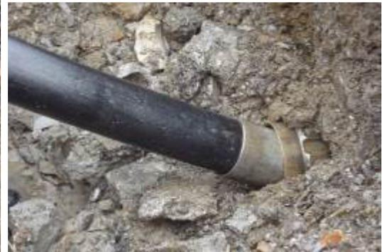
Расширительный конус «разводит» осколки в разные стороны, обеспечивая канал для новой трубы.
