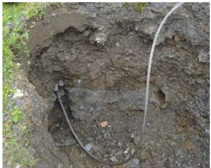
Трос пропускается через разрушитель и старую трубу.
