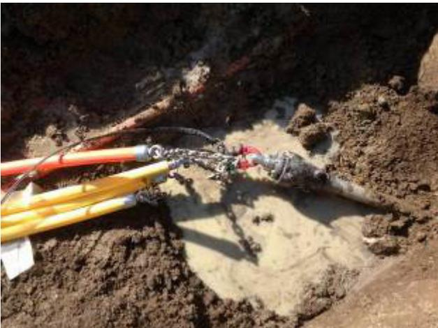
3-пальцевая буровая головка с корпусом для зонда обеспечила буровой канал для расширительной буровой головки со встроенным вертлюгом для затягивания одновременно несколько труб.
