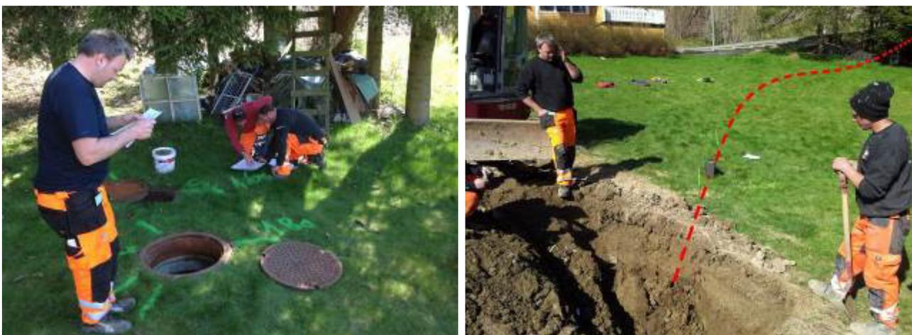
Общая длина бурения 55 м в тяжёлом грунте. Под дорогой находится гравий и каменные глыбы. Уже при бурении первой буровой штанги (3 м) изменение направления бурения «пошло» вверх. Дальше бурение «по горизонту». При бурении трасса отслеживалась и маркировался путь прокладки для отслеживания заранее проложенного плана бурения до самой цели.
