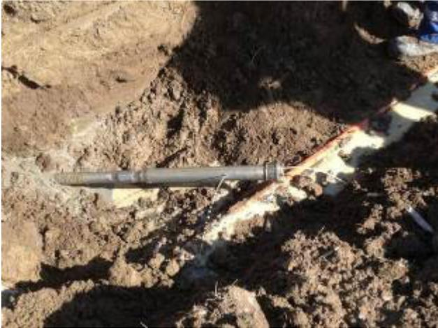
«Пилотка» достигла цели в приёмном котловане. Тройная буровая головка для сложных грунтов справилась с задачей.
