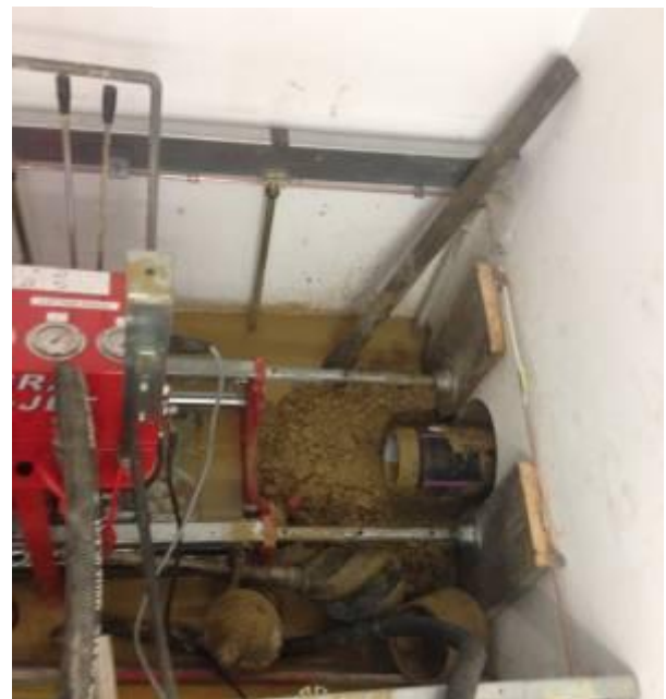
Короткие винтовые трубы смонтированы. Оставшееся отверстие заделано макрофлексом.
