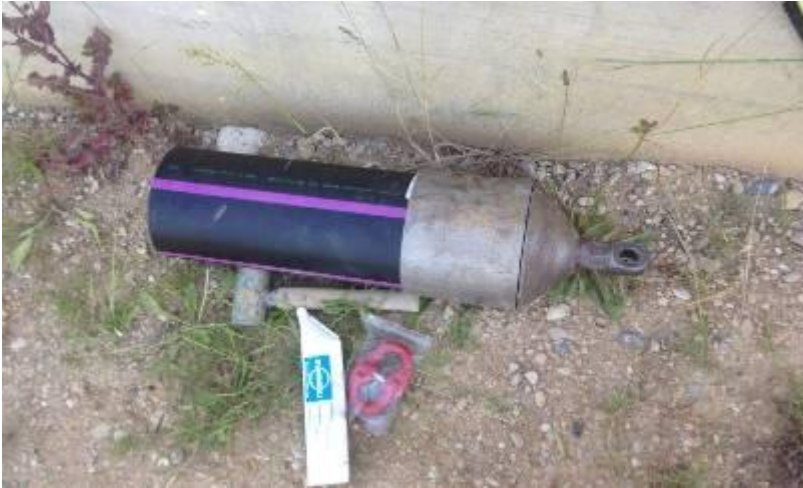
Держатель трубы смонтирован с первой короткой трубой. Остальные короткие трубы привинчивались непосредственно в колодце.
