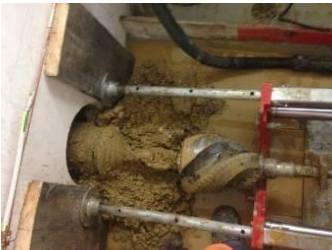
Держатель трубы смонтирован с первой короткой трубой. Остальные короткие трубы привинчивались непосредственно в колодце.
