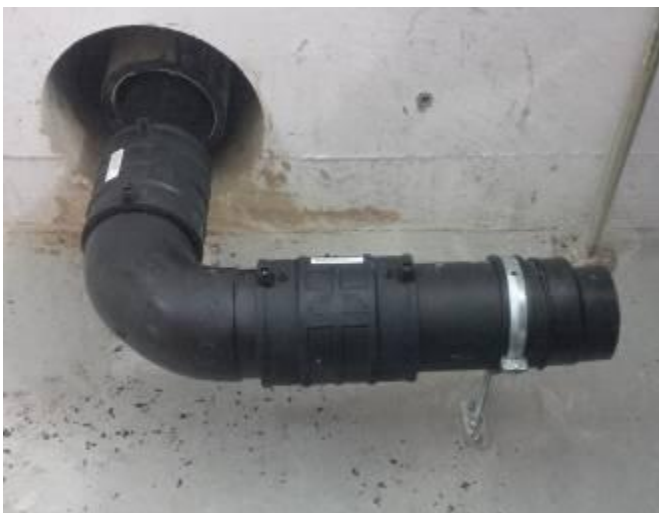
← Die Montage des Produktrohrs.
