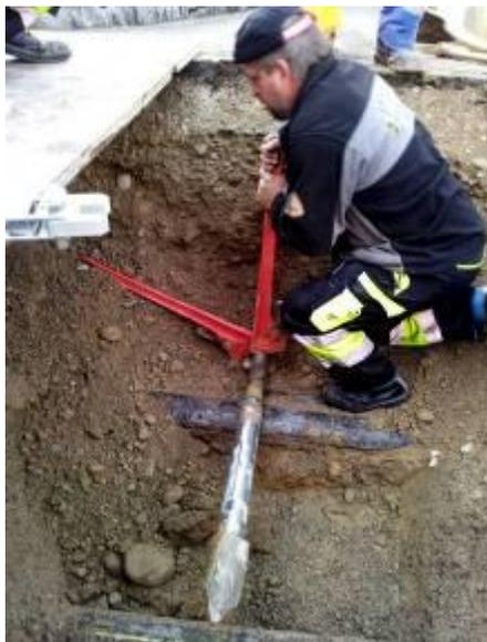
После «прибытия» буровой головки вместе с корпусом зонда к цели их нужно отвинтить и привинтить расширительную головку  $\varnothing$  160 мм. Вместе с расширительной головкой одновременно затягивается ПЭ-труба  $\varnothing$  125 мм.
