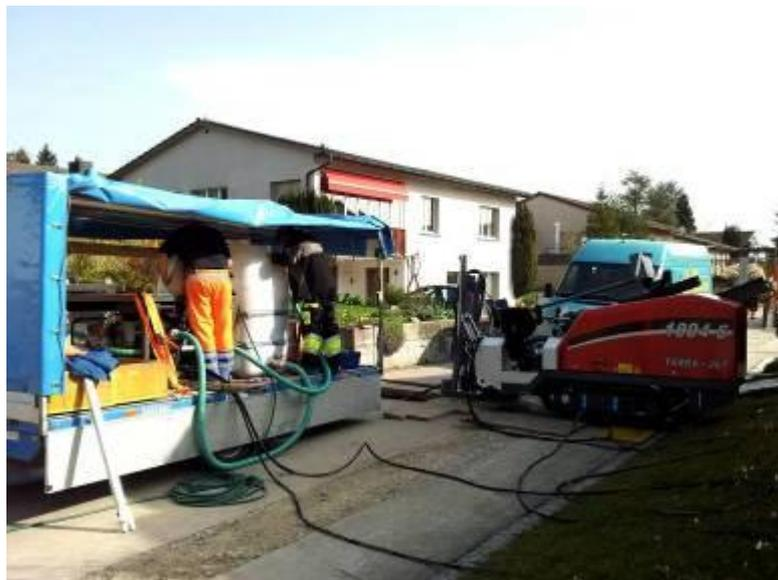
Смешиватель с баком и инструменты находятся на небольшом прицепе. Приготовление раствора путём засыпания бентонита в воронку так же делается на территории прицепа.
