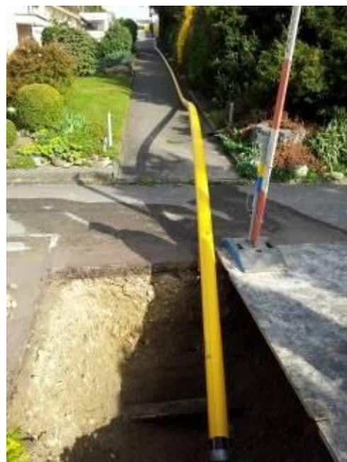
Защитная труба затянута. Длина 49 м. Пилотка и затягивание трубы заняло по времени половину дня.
