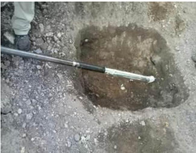
Для работы в тяжелом насыпном грунте и гравии использовалась трехпальцевая буровая головка, которая бурит подобные грунты без каких-либо проблем.
