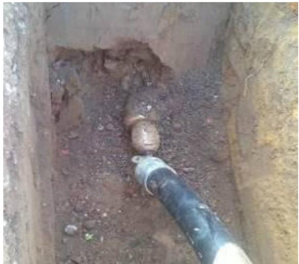
Для протяжки трубы использовался расширитель  $\varnothing$  115 мм с вставками из твердосплавного металла. Благодаря новому конструктивному решению компании TERRA AG, при котором двойной цилиндр оптимально передает усилие при протяжке, прокладка трубы через сложный грунт не представила никаких проблем.
