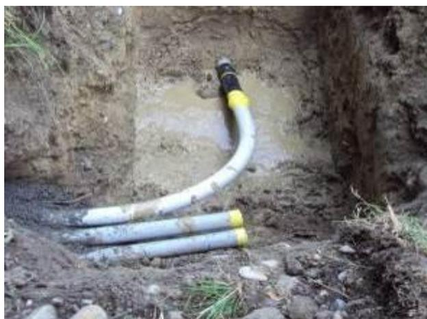
Трубопровод-футляр полностью протянут, кабель уже присоединен к трубе.
