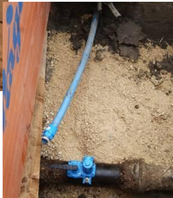
→ Подключение новой трубы к действующему водопроводу.
