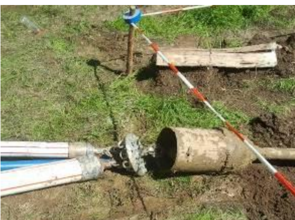
Расширитель \varnothing 360 мм со связкой труб (1x \varnothing 132 мм, 1x \varnothing 92 мм, 1x \varnothing 63 мм).
