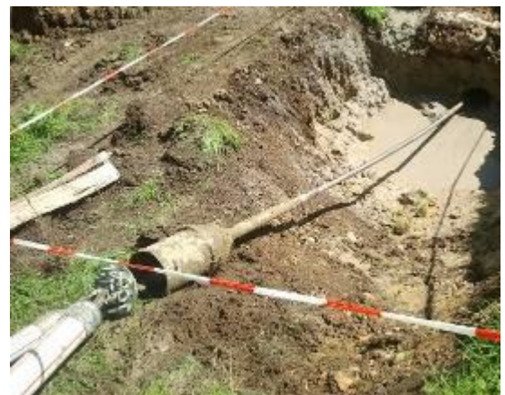
Приемный котлован перед началом протяжки труб.
