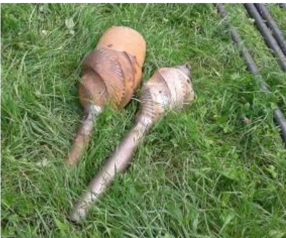
Пилотная скважина длиной 49 м была расширена двумя расширителями сначала до \varnothing 215 мм, а затем до \varnothing 360 мм.
