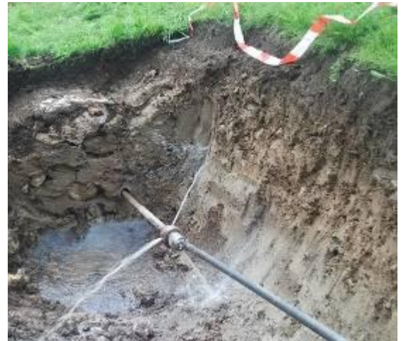
Начало промежуточного расширения \varnothing 215 мм.
