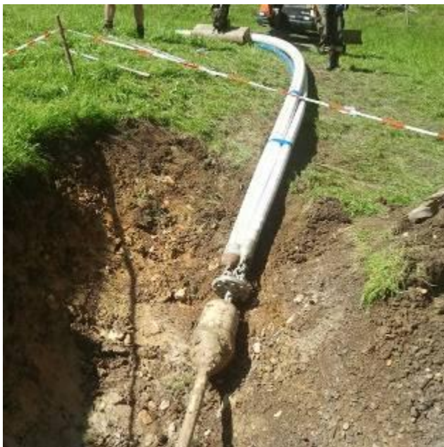
Начало протяжки труб.
