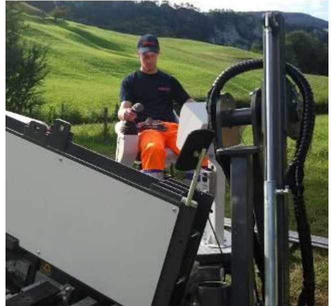
Оператор концентрируется на процессе пилотного бурения.
