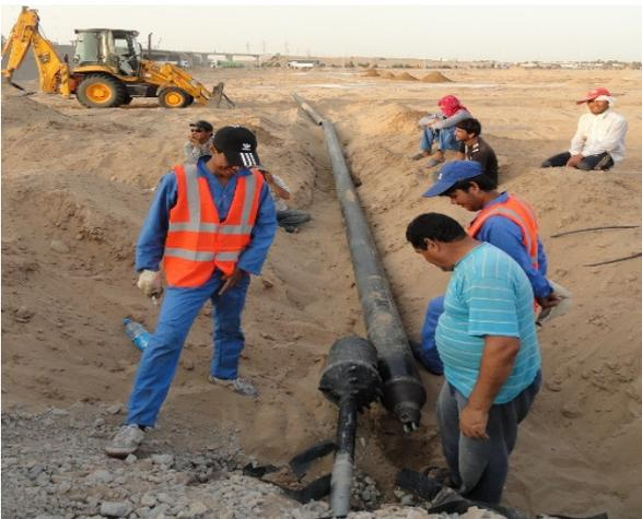
Стальная труба DA 324 мм соединяется с расширительной головкой  $\varnothing$  420 мм.
