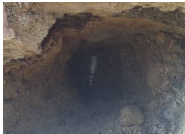
→ TERRA-HAMMER T 055 SK достигла цели в нужном месте.
