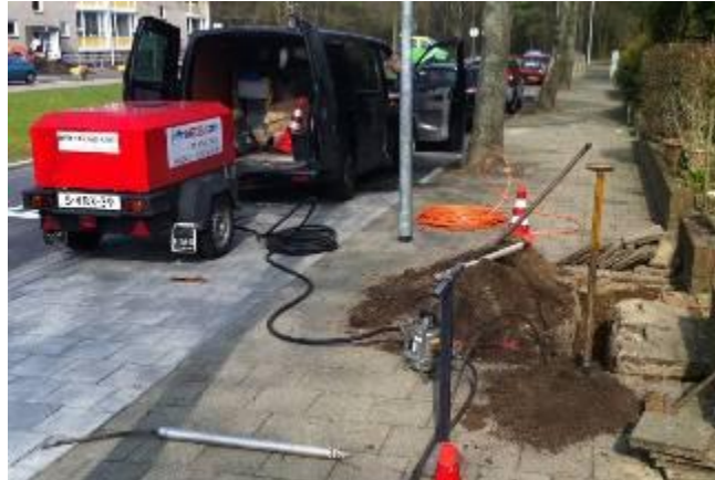
← Вид на стартовую траншею и компрессор.
