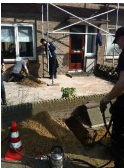
← TERRA-HAMMER T 055 SK за 5 минут достигла цели.
