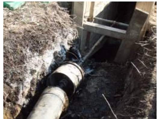
Затяжка HDPE-трубы DA 355 мм на длину 170 м с расширением в 520 мм.
