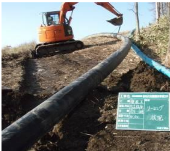
HDPE-труба 355 мм.
