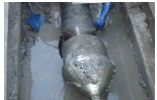
170 м пройдено расширительной головкой 520 мм с HDPE-трубой DA 195 мм.
