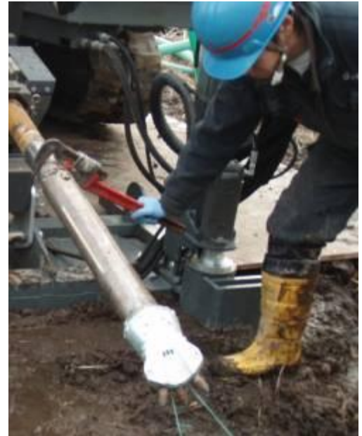
Трёхпальцевая головка делает «пилотку» в твёрдых грунтах.
