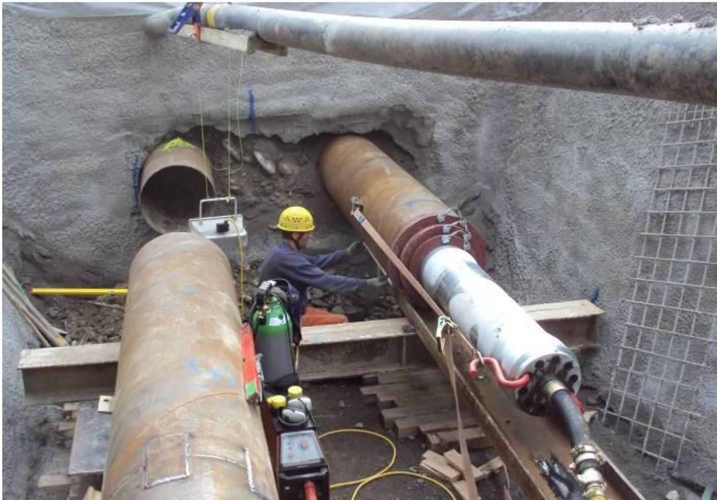
В местечке Wimmis, который находится в Бернском нагорье, необходимо забить 2 стальных трубы  $\varnothing$  600 мм, длиной 17 м под однопутной железной дорогой. Трубы предназначены для централизованного теплоснабжения. Строительное предприятие Vign решало выполнить эту работу с помощью TERRA-HAMMER TR 360.
