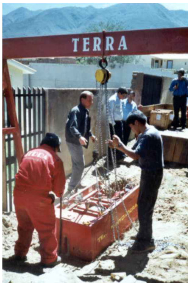
Фото наверху слева: TERRA-HYDROCRACK /короткая версия устанавливается в стартовую яму.
