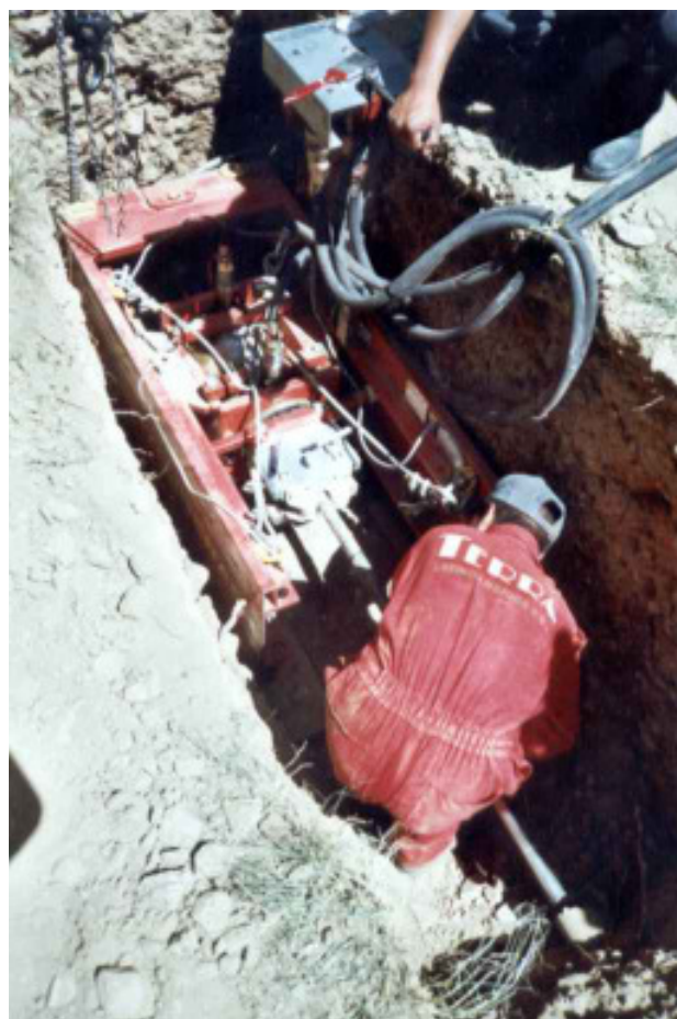
Фото наверху справа: За 1.5 часа буровые штанги прошли 100 метров по старой трубе.
