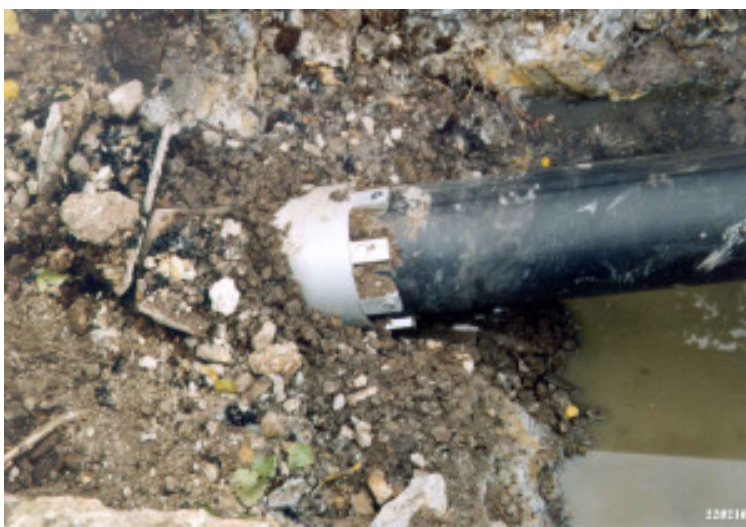
Фото слева: ПЭ-Труба наруж. \varnothing 315 мм, длиной 120 м, раскалывающая штанга 12" с трёхсторонним ножом с наружным \varnothing 368мм перед началом втягивания.
