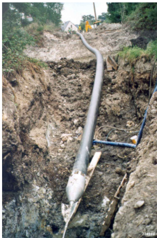
Фото слева: ПЭ-Труба наруж. \varnothing 315 мм, длиной 120 м, раскалывающая штанга 12" с трёхсторонним ножом с наружным \varnothing 368мм перед началом втягивания.
